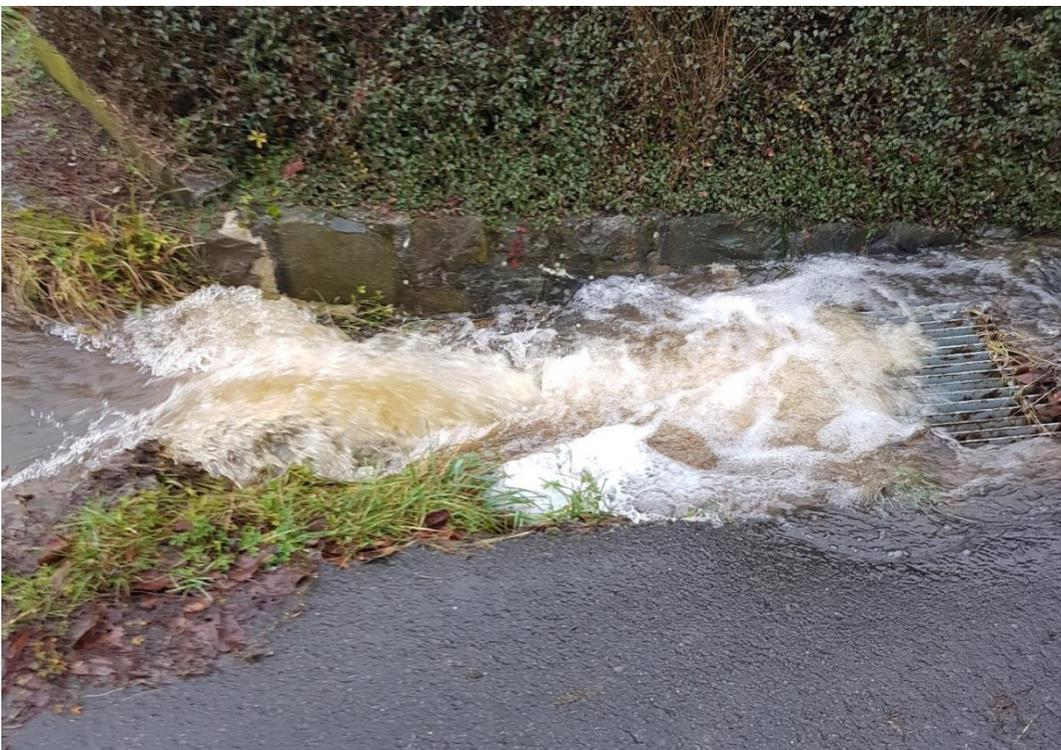
Abb. 5: Überlasteter Einlaufbereich in die Verrohrung der Außengebietsentwässerung beim Starkregenereignis 2017 (bereitgestellt durch die VG Herrstein-Rhaunen)
