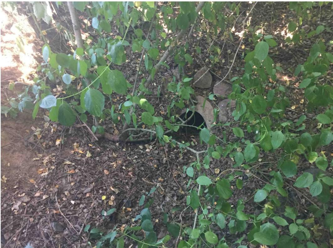
Beschreibung: Zugewachsener und zugesetzter Einlaufbereich der Verrohrung
