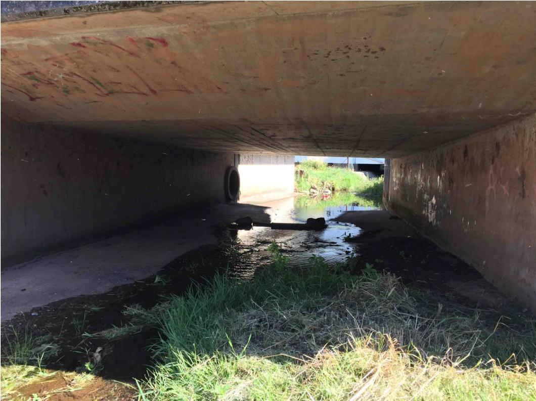
Beschreibung: Engstelle unter Brückenbauwerk mit Ablagerung von Treibgut
