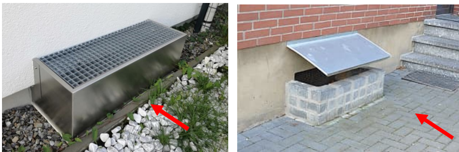
Abb. 17: Beispielbilder Erhöhung von Lichtschächten
