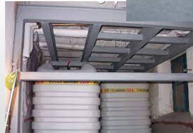
Variante 2 Tankanlage durch Verankerung sichern
