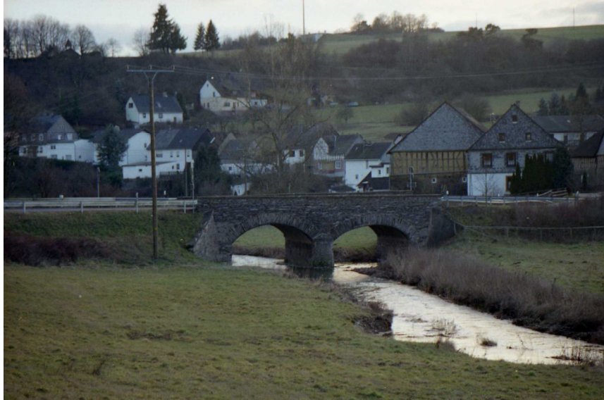
Brücke über den Kyrbach
